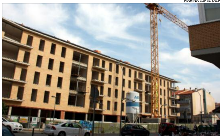
Un edifici a mitja construcció a la ciutat de Girona.
