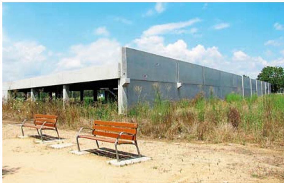
La galeria de tir plena d'herbes per l'aturada de les obres fa tres mesos ■ D.V.
