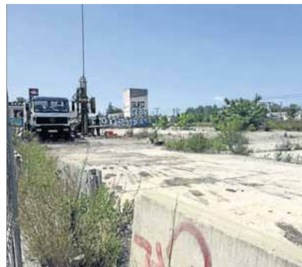
El juny de l'any passat es van fer prospeccions al subsol del solar on s'ha de fer la nova clínica ■ J.N.
