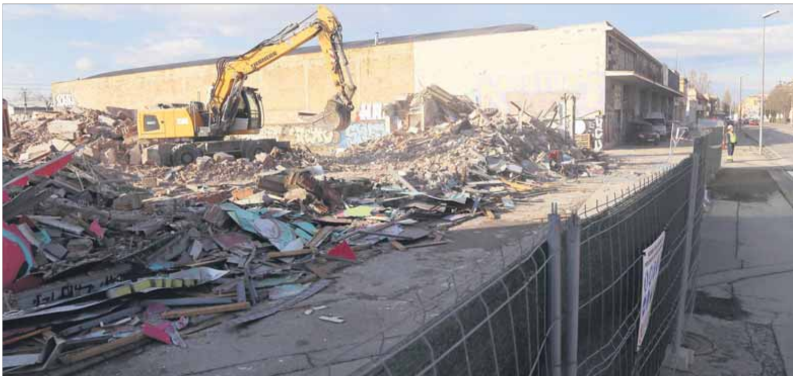
L'edifici de la Comiro estava gairebé tot a terra ahir a la tarda, amb les màquines que continuaven recollint la runa ■ QUIM PUIG
