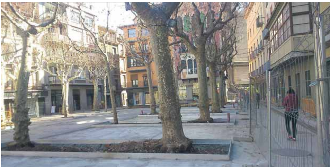
La part del passeig on estan aplicant formigó com a base del paviment, dissabte passat ■ R.E.
