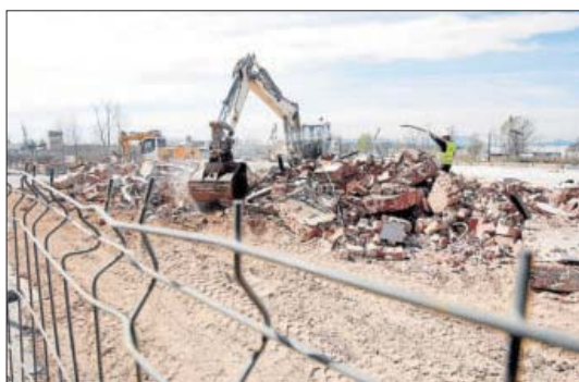
Obres d'enderroc i construcció de la Clínic. MARC MARTÍ
