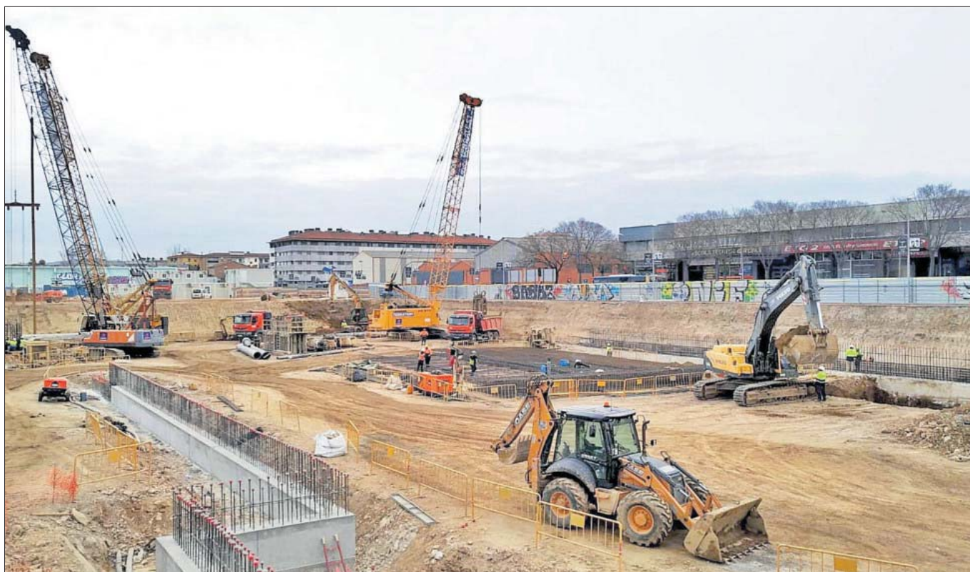
La futura Clínica Girona serà un gran edifici amb 3 plantes subterrànies i 7 per sobre del nivell del sòl, i passarà dels 13.000 m 2 actuals a 41.000 m 2 . DdG
