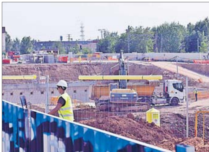
Les obres a la zona de la futura clínica, a la carretera Barcelona. MARC MARTÍ
